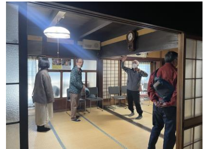
立派な差し鴨居（川田家住宅）
