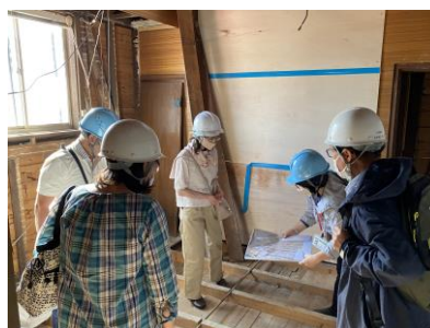
工事現場（日本福音ルーテル復活教会）
