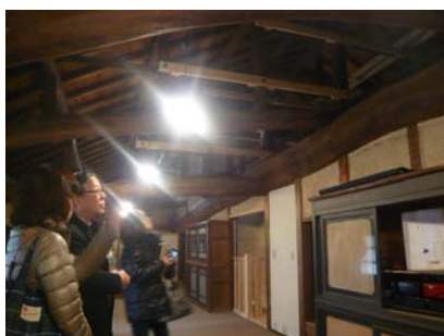
棚橋家住宅にて、改修を担当された三井氏より解説いただいた
