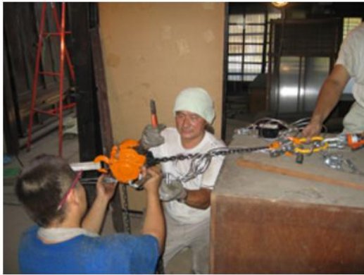
2005年9月 屋起こし（柱を垂直に修正）
