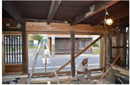
2014年9月 玄関入口の敷鴨居取付
