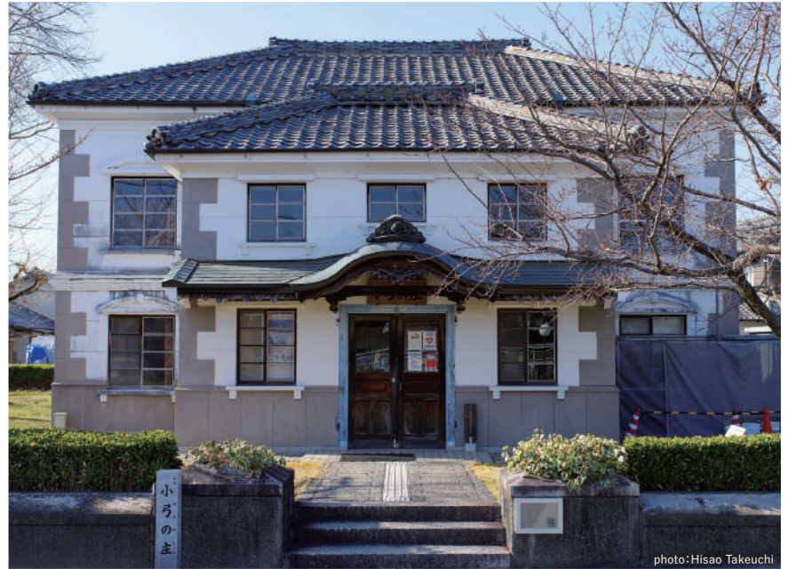
壁面は洋風、屋根は和風の外観。一番目につく唐破風には龍や鳳凰を配して和風を強調している
